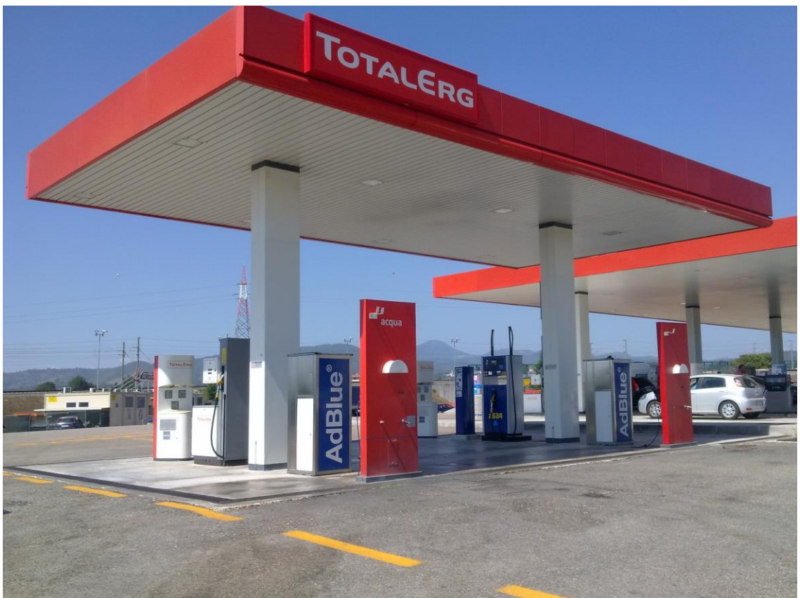
Stazione di rifornimento con erogatori AT30/U
